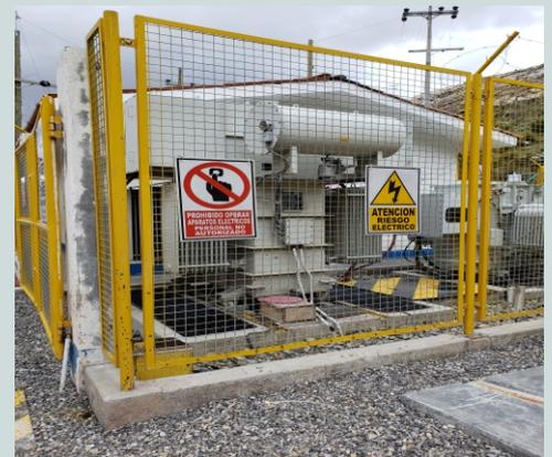
Instalación de transformador, revisión de equipos de protección y nivel de aceite.
