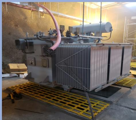
Instalación de transformadores 6MVA.
