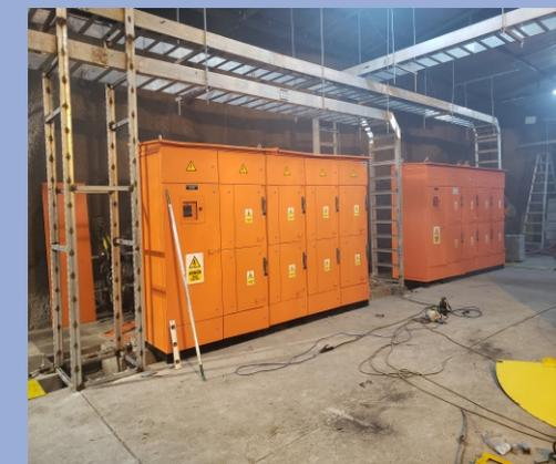
Instalación de Celdas, tableros de distribución, CCM, Banco de Condensadores.
